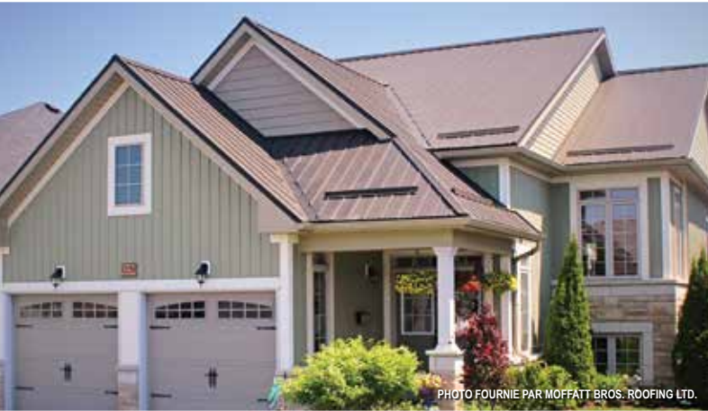
PHOTO FOURNIE PAR MOFFATT BROS. ROOFING LTD.
