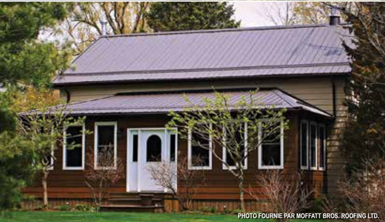
PHOTO FOURNIE PAR MOFFATT BROS. ROOFING LTD.
